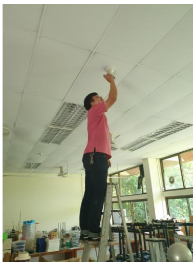
รูปที่ 5.1 การทดสอบ Smoke Detector
