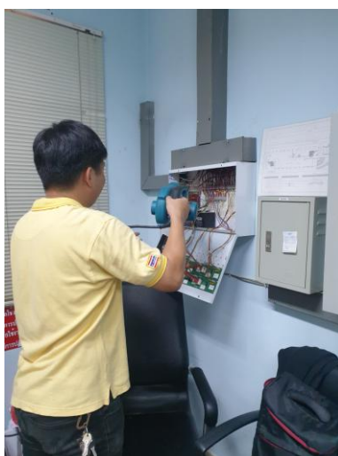
รูปที่ 5.5 ทำการตรวจเช็คและทำความสะอาดตู้ควบคุมสัญญาณเตือนเพลิงไหม้
