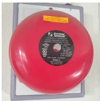
รูปที่ 5.8 ทดสอบกระดิ่ง และวัดค่าความดังตามมาตรฐาน
