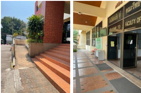
ทางลาดขึ้นอาคาร
