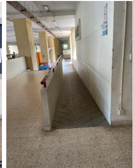
ทางลาดขึ้นอาคาร
