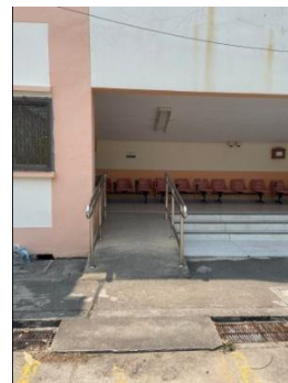
ทางลาดขึ้นอาคาร
