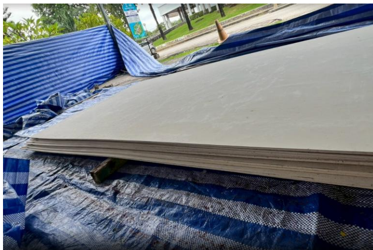
ภาพแสดง การกั้นพื้นที่บริเวณที่จะมีการก่อสร้าง ปรับปรุงในอาคารจุฬาภรณ์
